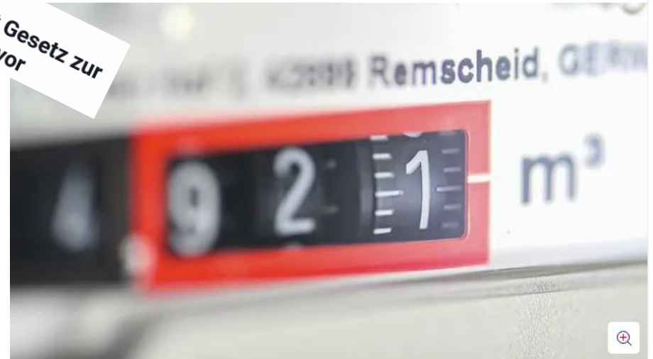
Ein Gaszähler für eine Gasheizung: Angesichts steigender CO2-Preise raten Verbraucherschützer vom Einbau neuer Gas- und Ölheizungen ab. (Quelle: Bernd Weißbrod/dpa/dpa-bilder)
